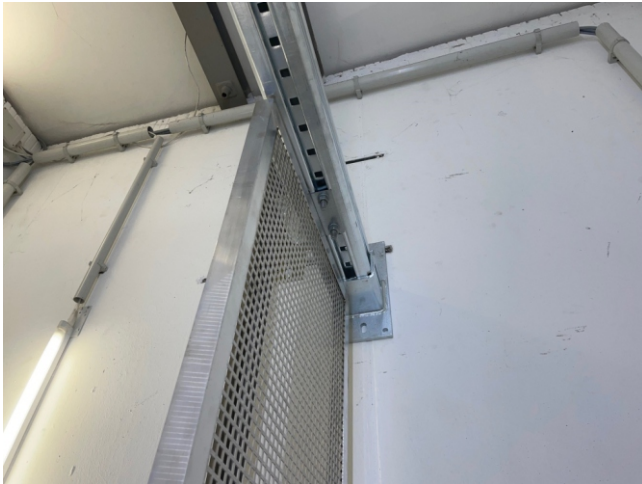
Bild 2: Befestigung mit Hammerkopfschrauben an einem Schwerlast-Schienensystem, oberes Ende des Trennwandelements B=520
