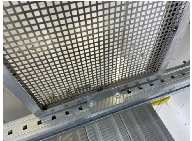
Bild 3: Befestigung mit Hammerkopfschrauben an einem Schwerlast-Schienensystem, unteres Ende des Trennwandelements B=520
