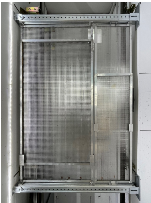
Bild 2: Befestigung mit Hammerkopfschrauben an einem Schwerlast-Schienensystem, oberes Ende des Trennwandelements B=520
