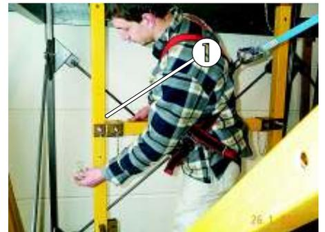
Bild 52: Steckbolzen zur Sicherung des Handlaufes
