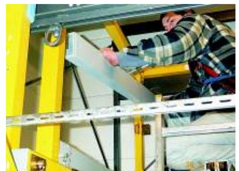
Auf die Gleichrichtung der Bolzen und die Verwendung der Sicherungssplinte muss geachtet werden.
