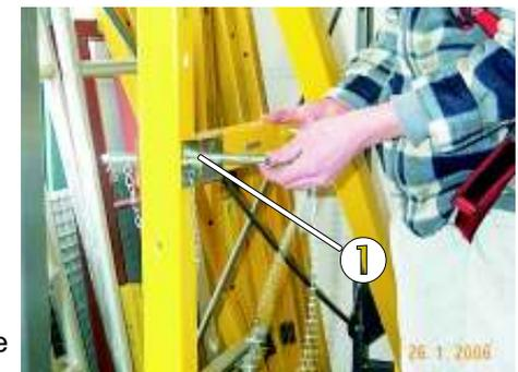
Bild 64: Fixierung der Handläufe
