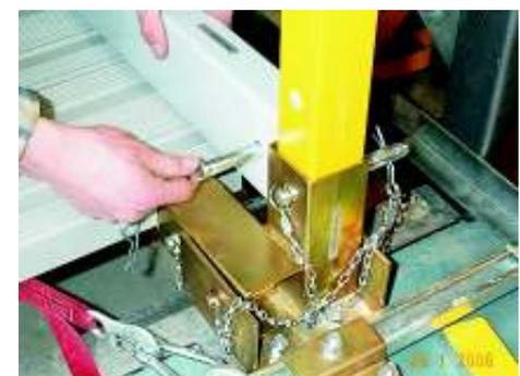
Auch an der hinteren kurzen stirnseitigen Seite der Bühne müssen Fuß- und Knieleisten (Bild 69 / Pos.1) mit kurzen Steckbolzen befestigt und gesichert werden.
