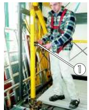
Bild 61: Montage der noch fehlenden Handläufe
