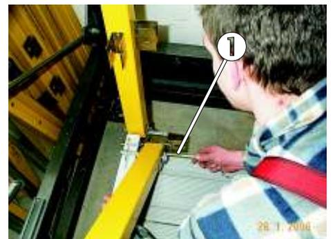
Bild 66: Befestigung der Fuß- und Knieleisten
