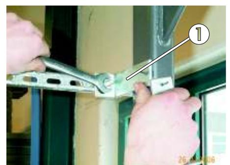
Bild 44: L-Profil für obere Quertraverse
