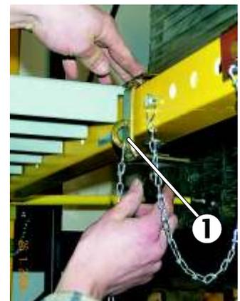
Bild 89: Rohrklammen gegen das Verrutschen der Bodenpaneele
