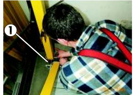
Bild 48: Sicherung mit kurzem Steckbolzen
