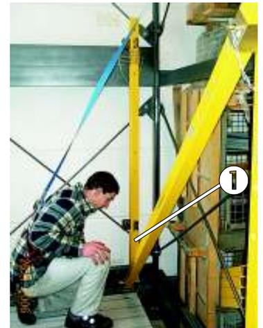
Bild 45: Einstecken der hinteren senkrechten Geländerstütze
