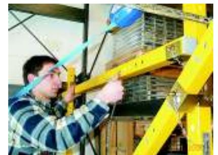
Im Weiteren werden die noch fehlenden Handläufe für den Seitenschutz in Längsrichtung montiert. Zu Beginn werden die vorderen Kreuzhalter in ca. 1 m Höhe an den senkrechten Dreiecksseiten mit einem kurzen Steckbolzen montiert und gesichert (Bild 61 / Pos.1).
