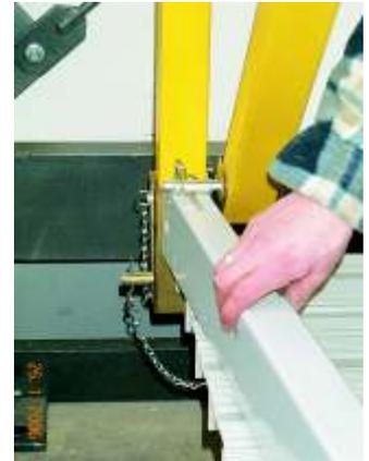
Nur bei den beiden hinteren Aufnahmeteilen, bei denen die diagonale und waagrechte Dreiecksseite sowie die hintere senkrechte Geländerstütze zusammenlaufen, muss ausnahmsweise ein langer Steckbolzen verwendet und gesichert werden (Bild 66 und Bild 67 / Pos. 1).
