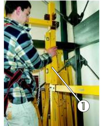
Nachdem die hinteren senkrechten Geländerstützen in Längsrichtung zur Bühne ins Wasser gebracht wurden (Bild 59 / Pos.1), müssen die oberen beiden waagrecht Aufleger in einer der Länge nach deckungsgleichen Bohrung des Innen- und Außenrohres mit einem kurzen Bolzen fixiert und gesichert werden (Bild 60 / Pos.1).
