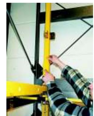
Für die vordere senkrechte Geländerstütze (oben) wird neben der Geländerstütze auch das passende Aufnahmeteil benötigt.
