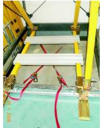
Nachdem die Spanngurte kreuzweise auf leichten Zug gebracht wurden, können die übrigen Paneele auf die beiden Dreieckselement von vorne aufgelegt und nach hinten verschoben werden (Bild 32 / Pos. 1).
