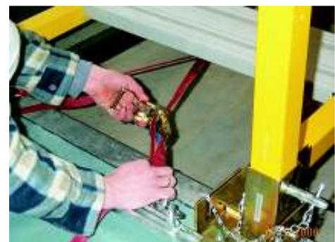
Durch das abwechselnde Verspannen sollen die Gurte nur eine geringe Vorspannung erhalten. Die endgültige Spannung wird erst nach dem vollflächigen Verlegen der Paneele durchgeführt (Bild 30 / Pos. 1).
