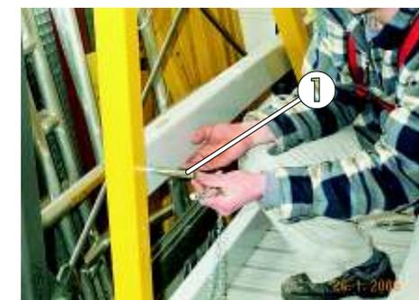
Bild 72: Bolzensicherung zur Montage der Knieleiste
