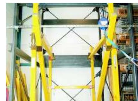
Bild 59: Ausrichtung der hinteren senkrechten Geländerstützen
