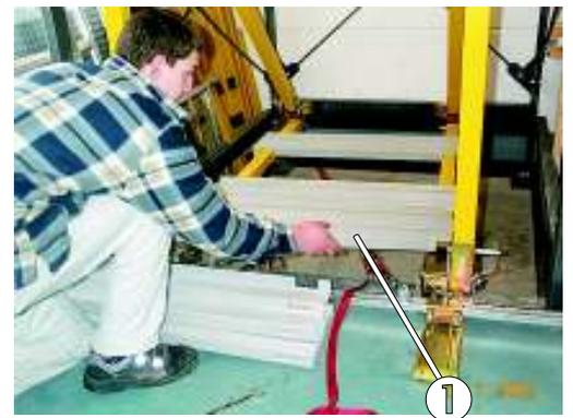
Bild 32: Auflegen weiterer Bodenpaneele
