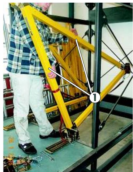
Bild 14: Kippen des Dreieckselementes an den Türsturz
