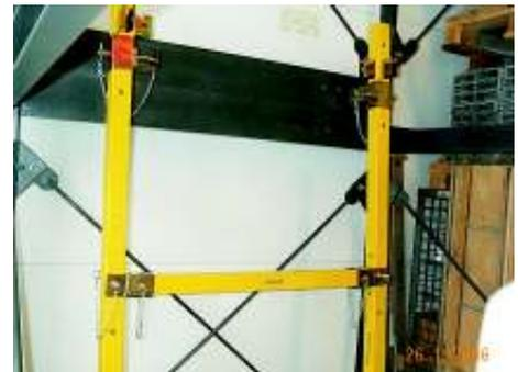
Auf die Gleichrichtung und Kettenführung der Steckbolzen sollte geachtet werden (Bild 53 / Pos. 1).
