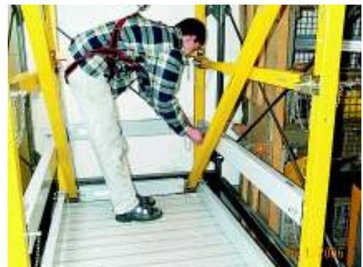
Der Aufbau des dreiseitigen Seitenschutzes, bestehend aus Handlauf, Knie- und Fußleisten ist somit abgeschlossen und sollte sich wie in Bild 73 darstellen.
