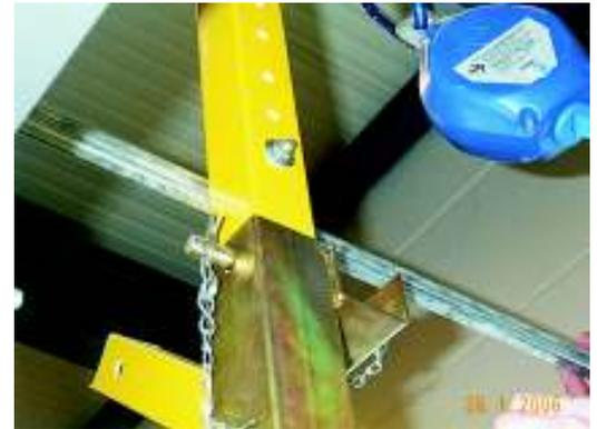
Mit einem Gabelschlüssel können die beiden Sechskantmuttern leicht angezogen werden. Dabei soll die große Unterlegscheibe die auftretenden Kräfte gut verteilen (Bild 41 / Pos.1).
