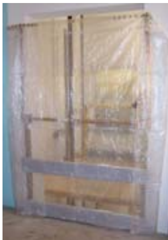
Variante 2: Vollabdeckung der Türöffnung zum Aufzugsschacht
