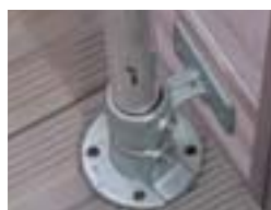
Wahlweise Befestigung der Geländerstütze vertikal oder horizontal
