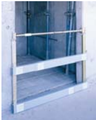
Variante 1: Teilabdeckung nach BGI 807/10.02 und BGG 928/04.94
