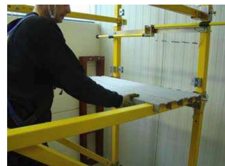
Fig. 77 : Pose des panneaux de plancher panneau de sol
