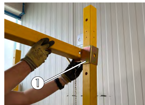
Bild 55: Hinterer Aufleger muss während der Montage festgehalten
