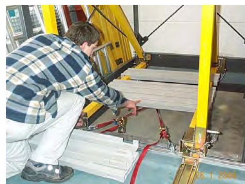
Fig. 32 : Pose sur des panneaux de plancher supplémentaires
