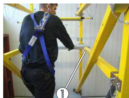
Fig. 77 : Pose des panneaux de plancher panneau de sol
