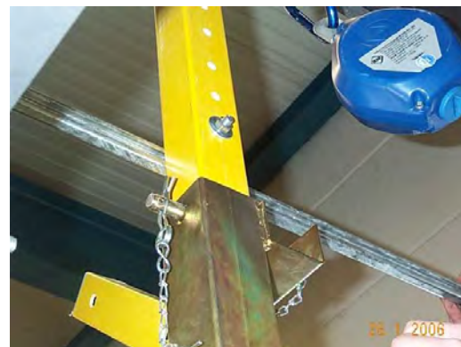
Fig.40 : Fixation de la traverse supérieure
