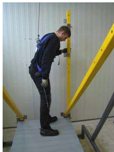
Fig. 45 : Insertion du montant vertical arrière du garde-corps
