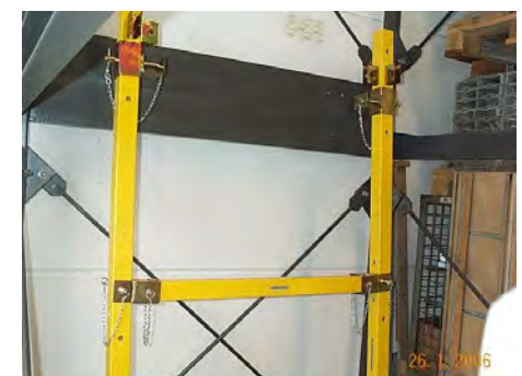
Fig. 52 : Goujon enfichable pour la sécurisation du support longitudinal
