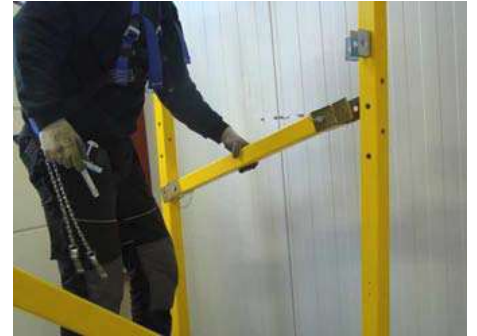
Fig. 51 : Assemblage de l'arrière du support longitudinal
