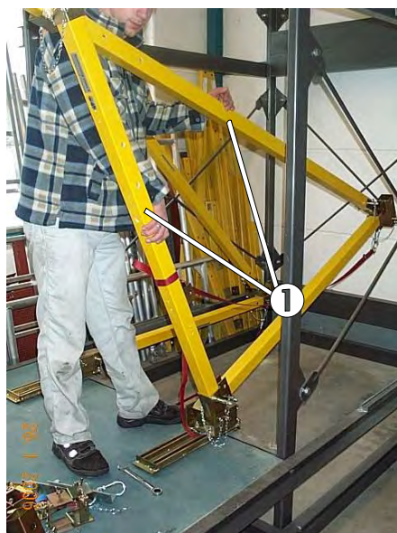
Fig. 14 : Basculement de l'élément triangulaire au niveau du linteau
