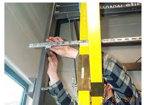
Fig. 43 : Fixation du deuxième profil en L
