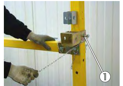
Fig. 62 : Montage des fixations en croix
