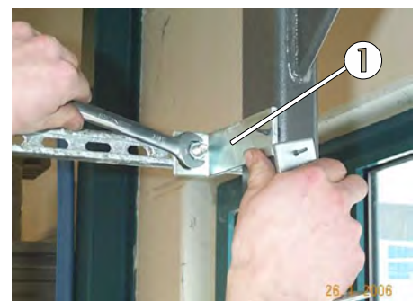
Fig. 44 : profil en L pour la traverse supérieure
