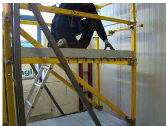
Figure 91: Fixation de la plinthe
