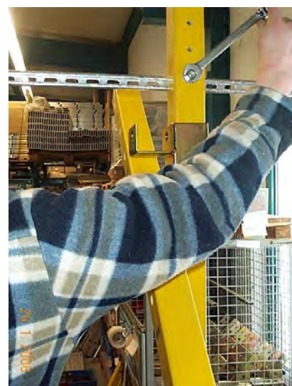
Fig. 41: Insertion de la rondelle pour la répartition des forces
