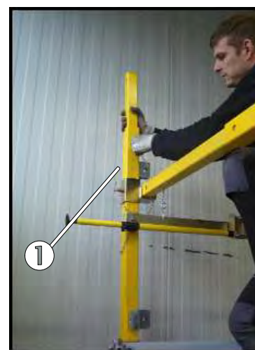
Fig. 73 : Sécurisation du montant vertical supérieur du garde-corps
