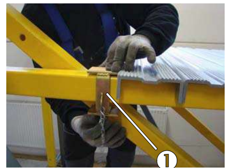
Fig. 82 : Colliers de serrage contre le glissement des panneaux de plancher
