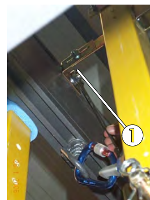
Fig. 84 : Fixation de l'ancrage murale
