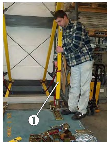
Fig. 15 : Levage de l'élément triangulaire
