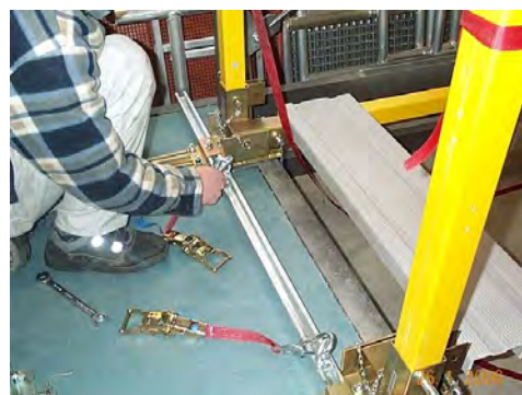
Fig. 24 : Les pièces courtes sont respectivement fixées à l'aide d'un mousqueton
