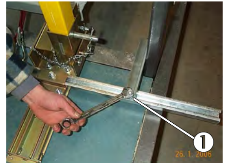
Fig.42: Profils L pour ancrage de la plateforme entre l'ouverture de la porte
