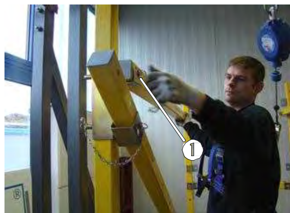
Fig. 58 : Enfichement aligné des goujons
