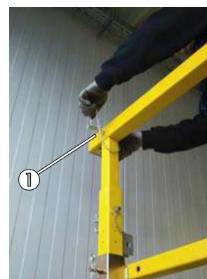
Fig. 86 : Le tube extérieur de la main courante est emboîté sur le montant vertical arrière
