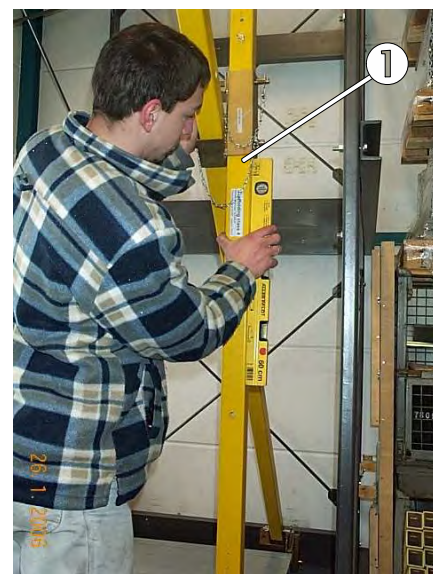
Fig. 38 : Alignement du côté vertical avant du triangle(droite)
