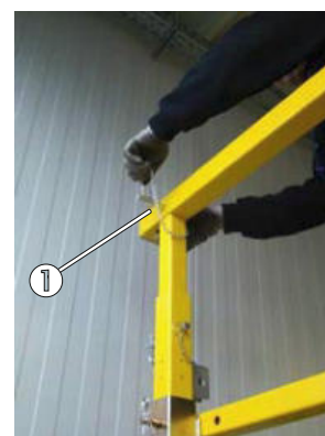
Bild 86: Das Außenrohr des Handlaufes wird über die hintere senkrechte Geländerstütze aufgesteckt
