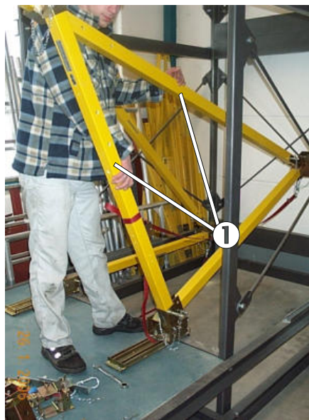
Bild 14: Kippen des Dreieckselementes an den Türsturz
