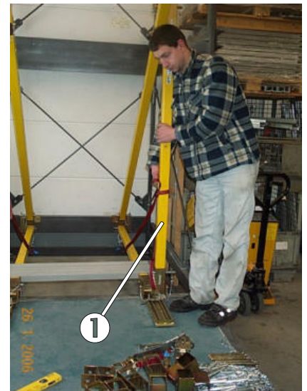
Bild 15: Anheben des Dreieckselementes
