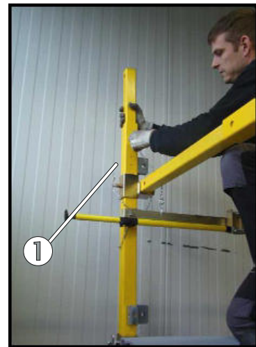
Bild 73: Sicherung der oberen senkrechten Geländerstütze
