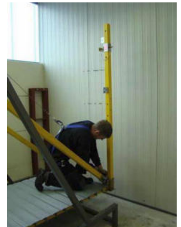
Bild 46: Bolzensicherung für die hintere senkrechte Geländerstütze
