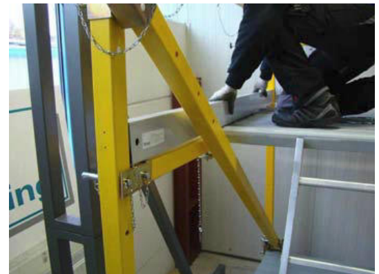
Bild 90: Der Steckbolzen wird zur Sicherung von oben eingeführt
