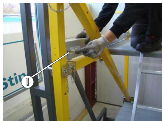
Bild 91: Sicherung der Fußleiste
