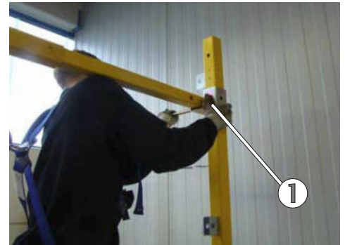
Bild 54: Aufnahmepunkte der oberen waagrechten Aufleger
