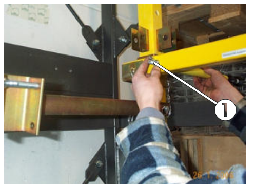
Bild 69: Alternative Befestigung der Teleskopstangen
