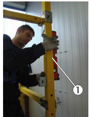
Bild 59: Ausrichtung der hinteren senkrechten Geländerstützen
