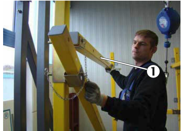
Bild 57: Gegenüberliegende zweite Knieleiste
