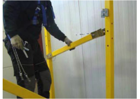
Bild 51: Montage des hinteren Längsauflegers
