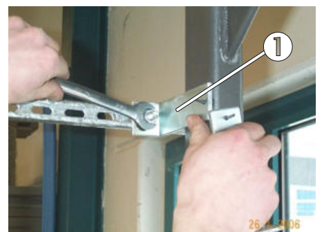
Bild 44: L-Profil für obere Quertraverse
