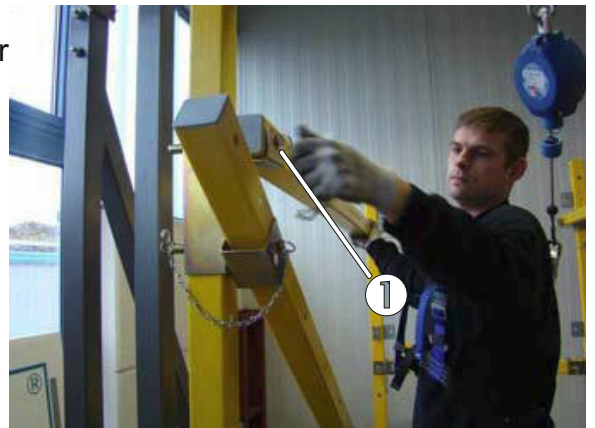
Bild 58: Gleichgerichtetes Stecken der Bolzen
