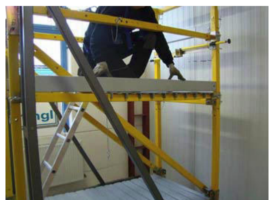
Bild 91: Sicherung der Fußleiste
