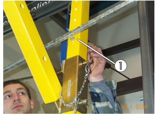
Bild 40: Fixierung der oberen Quertraverse
