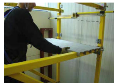
Bild 77: Auflagen der oberen Bodenpaneele
