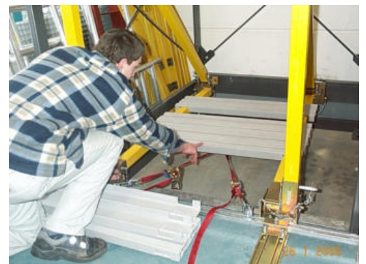
Bild 32: Auflegen weiterer Bodenpaneele
