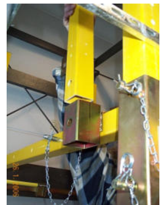
Bild 76: Positionierung des Aufnahmeteils inklusive oberer Geländerstütze
