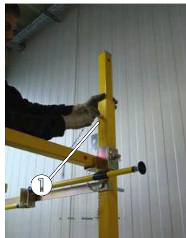
Bild 73: Sicherung der oberen senkrechten Geländerstütze
