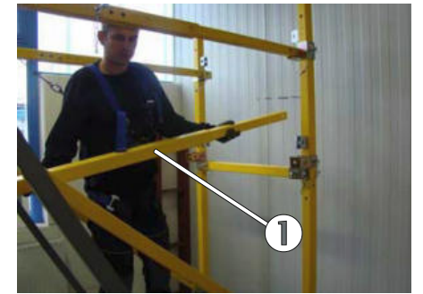
Bild 63: Auf das richtige Außenrohr muss geachtet werden
