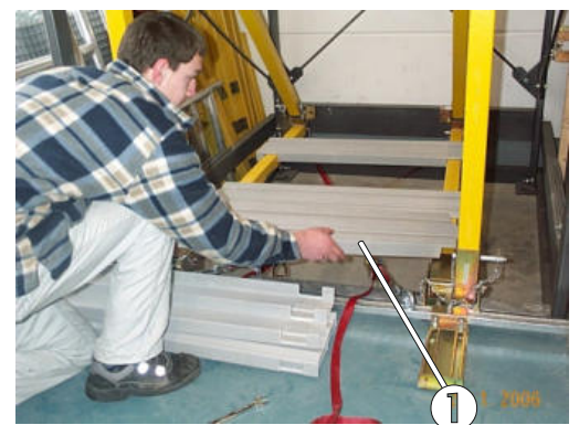
Bild 32: Auflegen weiterer Bodenpaneele
