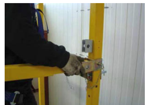
Bild 64: Fixierung der Panelaufleger
