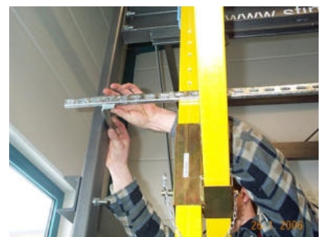
Bild 43: Anbringung des zweiten L-Profils
