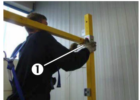
Bild 55: Hinterer Aufleger muss während der Montage festgehalten werden
