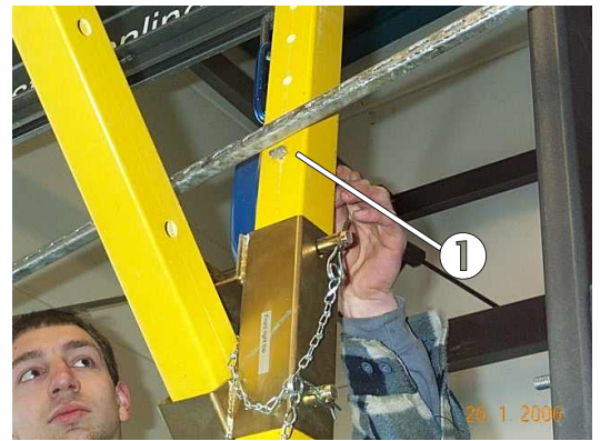
Bild 40: Fixierung der oberen Quertraverse
