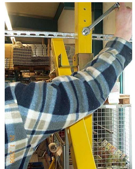
Bild 41: Einlegen der Unterlegscheibe zur Verteilung der Kräfte
