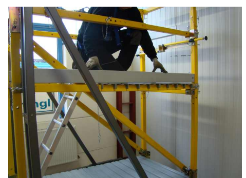
Bild 89: Sicherung der Fußleiste
