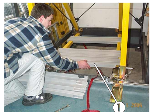
Bild 32: Auflegen weiterer Bodenpaneele
