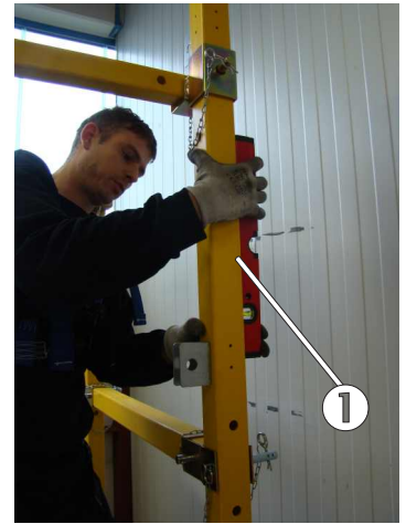
Bild 59: Ausrichtung der hinteren senkrechten Geländerstützen
