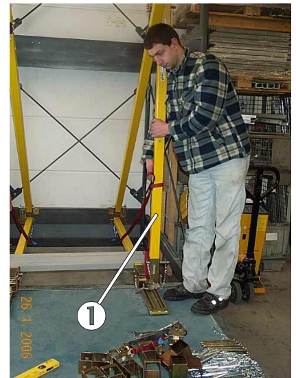
Bild 15: Anheben des Dreieckselementes
