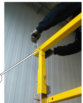
Bild 85: Das Außenrohr des Handlaufes wird über die hintere senkrechte Geländerstütze aufgesteckt
