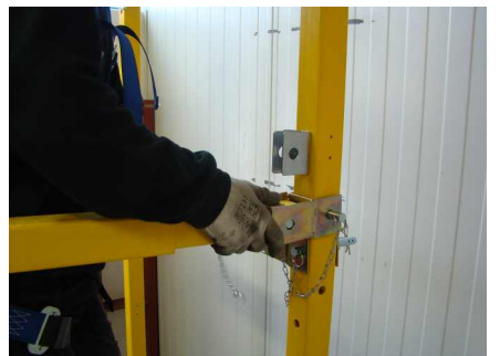
Bild 64: Fixierung der Handläufe
