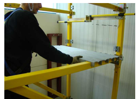
Bild 77: Auflegen der oberen Bodenpaneele auf Handlauf
