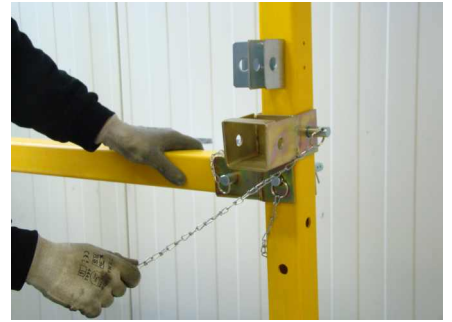
Bild 62: Montage der Kreuzhalter
