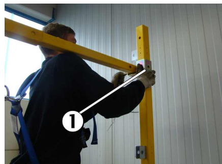
Bild 55: Hinterer Aufleger muss während der Montage festgehalten werden
