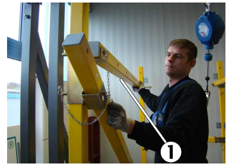
Bild 57: Gegenüberliegende zweite Auflager
