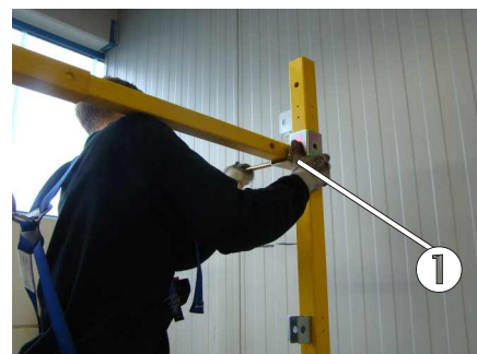
Bild 54: Aufnahmepunkt hinten des oberen waagrechten Aufleger
