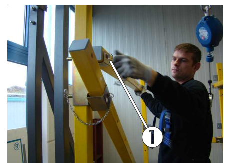
Bild 58: Gleichgerichtetes Stecken der Bolzen
