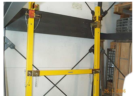
Bild 52: Steckbolzen zur Sicherung des Handlaufes
