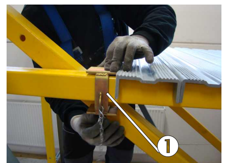
Bild 81: Rohrklammern gegen das Verrutschen der Bodenpaneele
