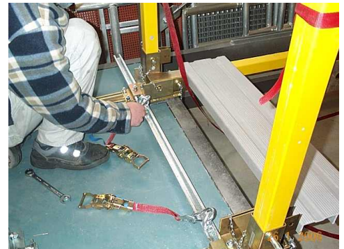
Bild 24: Die Kurzstücke werden jeweils mit Hilfe eines Karabinerhakens fixiert
