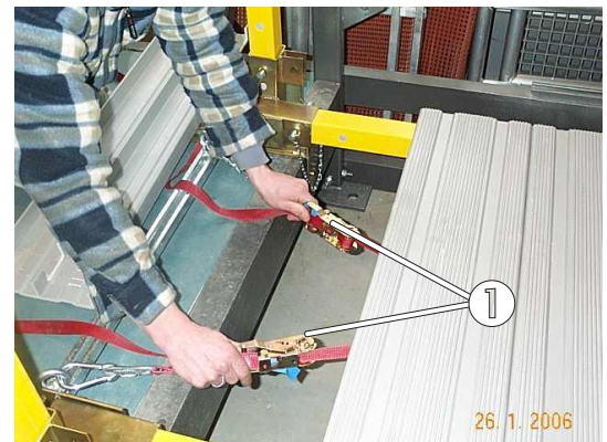
Bild 34: Ratsche anlegen und Spanngurtreste in den Aufzugschacht hängen
