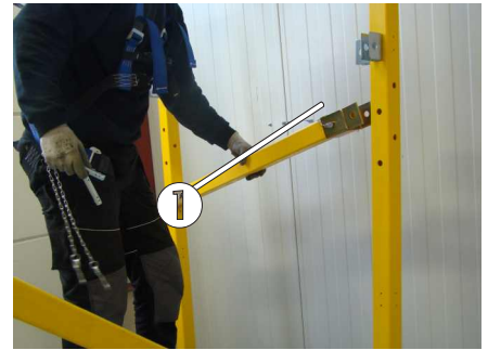
Bild 51: Montage des hinteren Handlaufes
