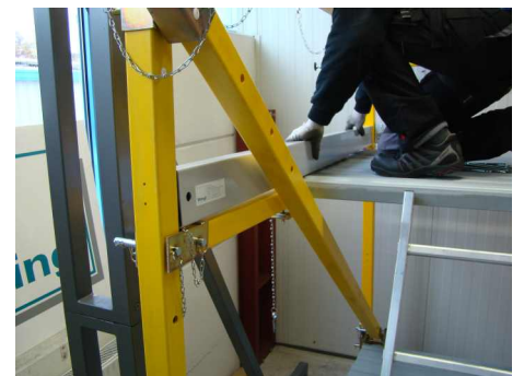
Bild 88: Der Steckbolzen wird zur Sicherung von oben eingeführt
