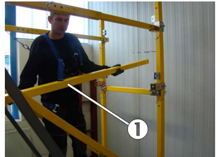
Bild 63: Auf das richtige Außenrohr muss geachtet werden
