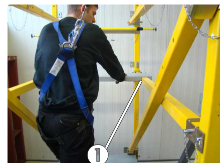
Bild 77: Auflegen der oberen Bodenpaneele auf Handlauf
