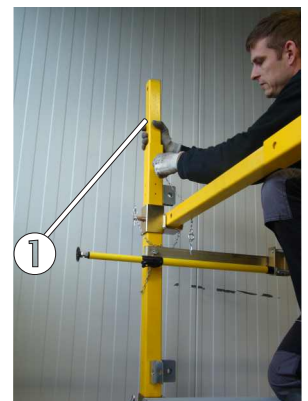
Bild 74: Zweite gegenüberliegende Geländerstütze
