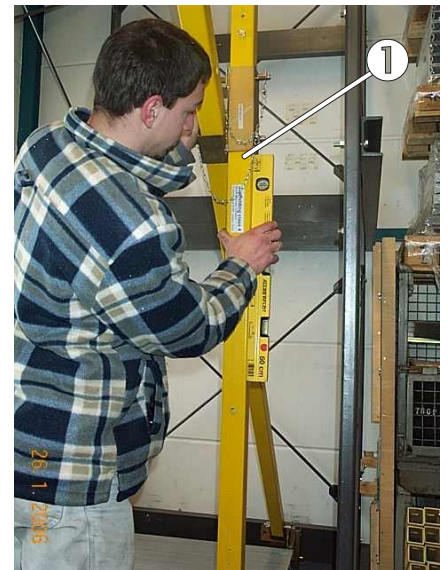
Bild 38: Ausrichten der vorderen senkrechten Dreiecksseite (rechts)
