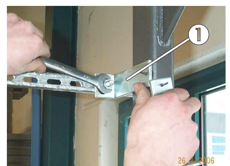
Bild 44: L-Profil für obere Quertraverse
