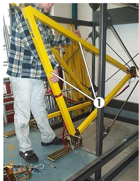
Bild 14: Kippen des Dreieckselementes an den Türsturz
