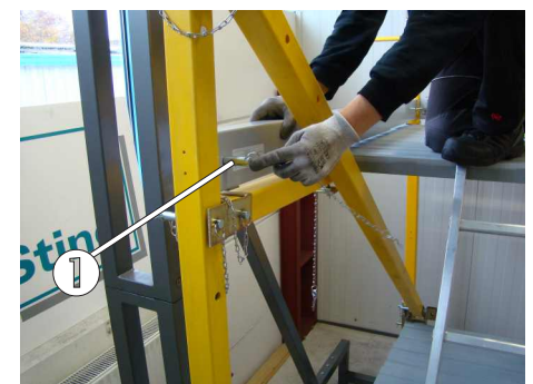
Bild 89: Sicherung der Fußleiste
