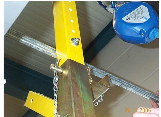
Bild 40: Fixierung der oberen Quertraverse
