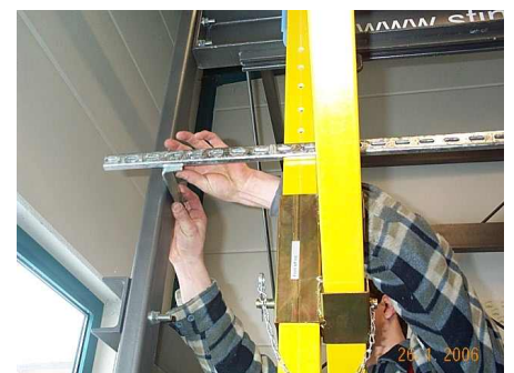
Bild 43: Anbringung des zweiten L-Profils
