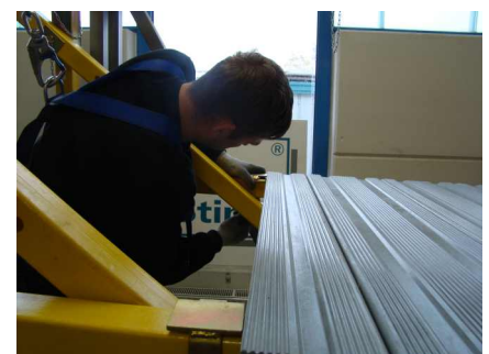
Bild 81: Rohrklammern gegen das Verrutschen der Bodenpaneele
