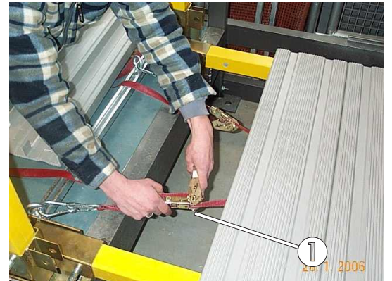
Bild 33: Gleichmässiges Aufbringen der maximalen Spannkraft.
