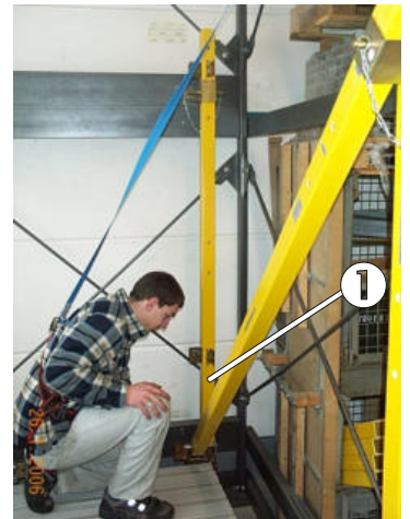
Bild 45: Einstecken der hinteren senkrechten Geländerstütze
