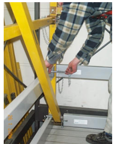
Bild 72: Bolzensicherung zur Montage der Knieleiste
