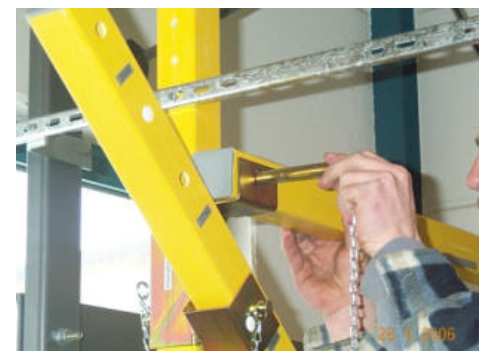
Bild 58: Gleichgerichtetes Stecken der Bolzen
