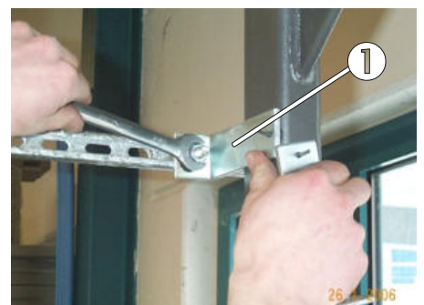
Bild 44: L-Profil für obere Quertraverse
