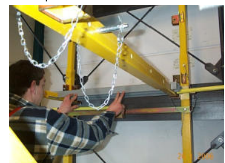
Bild 85: Auflegen der oberen Bodenpaneele
