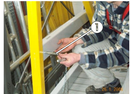
Bild 72: Bolzensicherung zur Montage der Knieleiste
