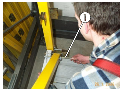
Bild 66: Befestigung der Fuß- und Knieleisten
