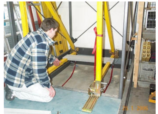
Bild 16: Erste Standardpaneele auflegen
