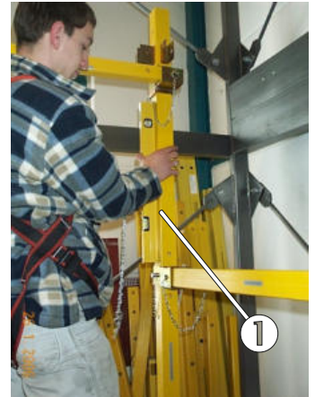
Bild 59: Ausrichtung der hinteren senkrechten Geländerstützen
