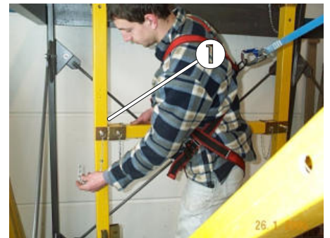
Bild 52: Steckbolzen zur Sicherung des Handlaufes
