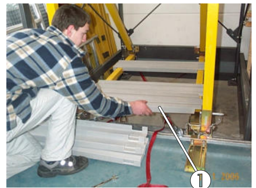
Bild 32: Auflegen weiterer Bodenpaneele
