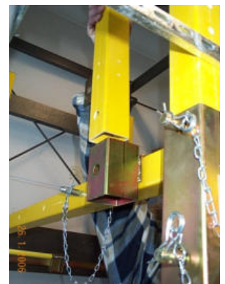
Bild 84: Positionierung des Aufnahmeteils inklusive oberer Geländerstütze
