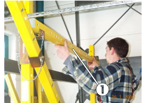
Bild 57: Gegenüberliegende zweite Auflager
