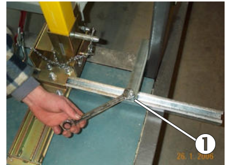
Bild 42: L-Profile zur Verankerung der Bühne zwischen der Türöffnung
