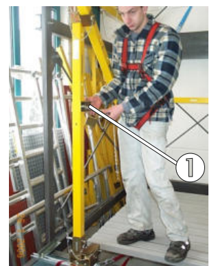
Bild 61: Montage der noch fehlenden Handläufe
