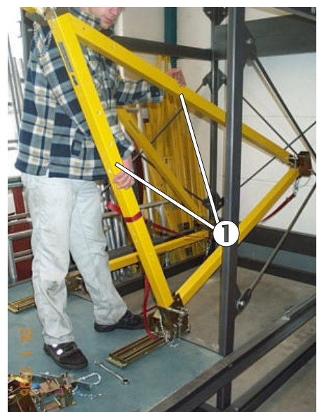
Bild 14: Kippen des Dreieckselementes an den Türsturz
