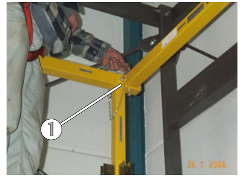
Bild 96: Auflegen und Sicherung des oberen stirnseitigen Handlaufes
