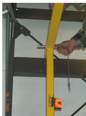
Bild 94: Das Außenrohr des Handlaufes wird über die hintere senkrechte Geländerstütze aufgesteckt
