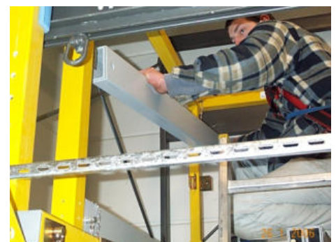
Bild 98: Sicherung der Fußleiste
