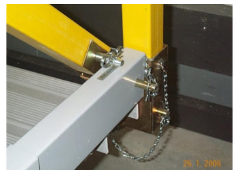
Bild 68: Verwendung eines langen Steckbolzen zur Fixierung der Fussleiste hinten rechts
