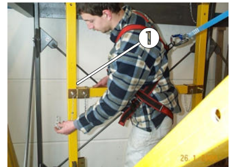
Bild 52: Steckbolzen zur Sicherung des Handlaufes
