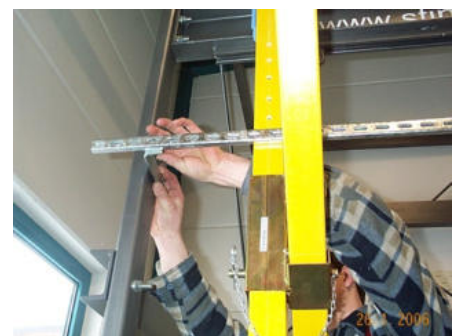
Bild 43: Anbringung des zweiten L-Profils
