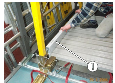
Bild 65: Montage der Fußleiste
