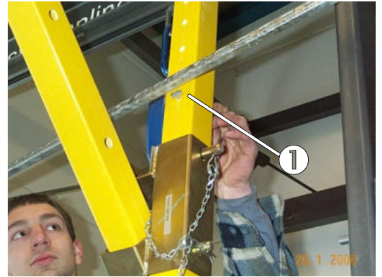
Bild 40: Fixierung der oberen Quertraverse
