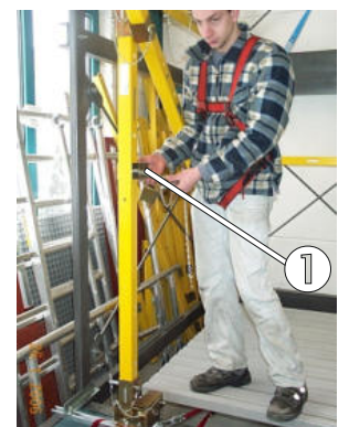
Bild 61: Montage der noch fehlenden Handläufe
