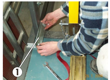
Bild 43: Anbringung des zweiten L-Profils
