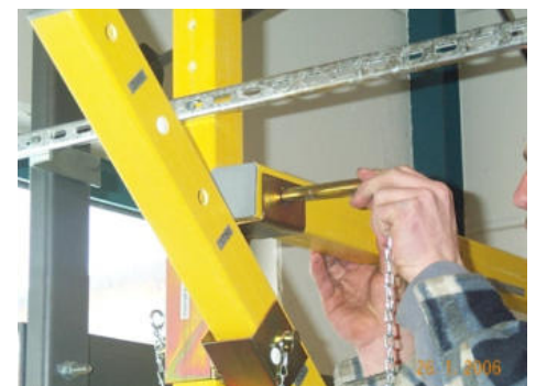
Bild 58: Gleichgerichtetes Stecken der Bolzen
