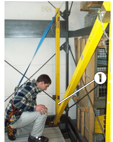
Bild 45: Einstecken der hinteren senkrechten Geländerstütze
