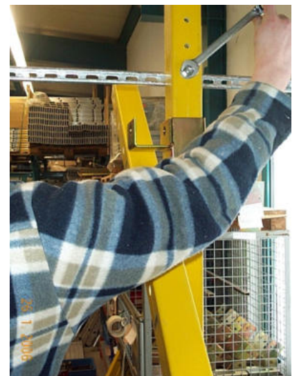
Bild 41: Einlegen der Unterlegscheibe zur Verteilung der Kräfte
