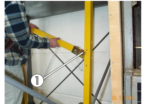
Bild 51: Montage des hinteren Handlaufes
