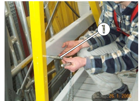
Bild 72: Bolzensicherung zur Montage der Knieleiste
