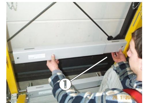
Bild 70: Befestigung der stirnseitigen Knieleiste
