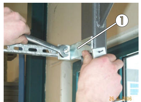
Bild 44: L-Profil für obere Quertraverse
