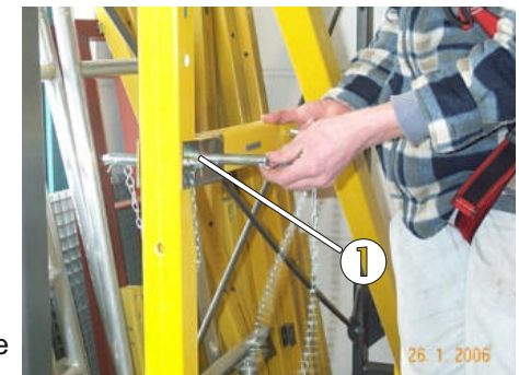
Bild 63: Auf das richtige Außenrohr muss geachtet werden
