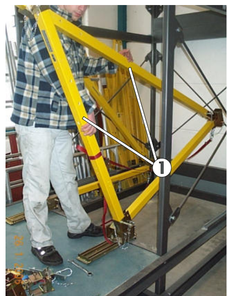
Bild 14: Kippen des Dreieckselementes an den Türsturz
