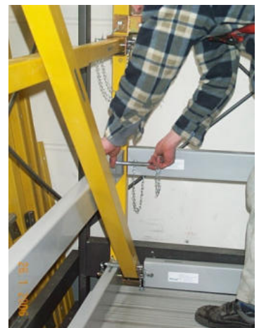
Bild 72: Bolzensicherung zur Montage der Knieleiste
