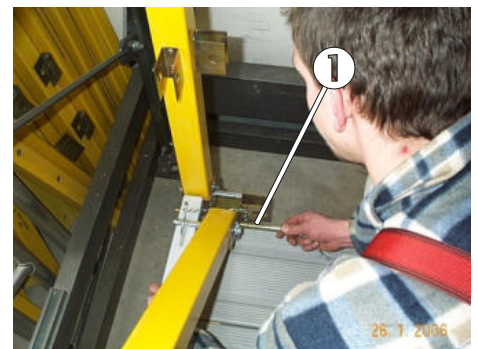
Bild 66: Befestigung der Fuß- und Knieleisten
