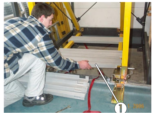
Bild 32: Auflegen weiterer Bodenpaneele
