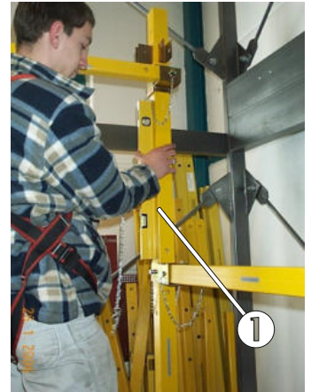
Bild 59: Ausrichtung der hinteren senkrechten Geländerstützen
