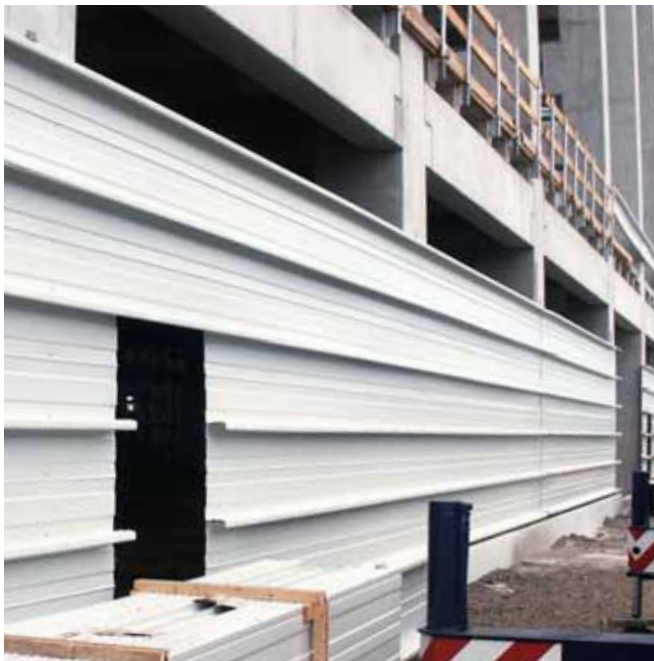
Montierte Fassadenbekleidung am Flughafen Köln/Bonn
