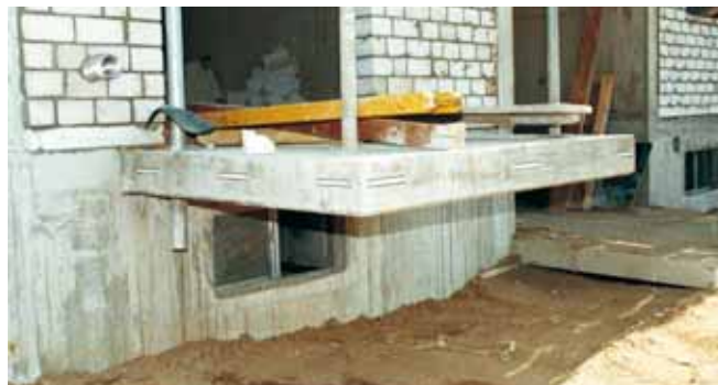
Fertig einbetonierte HGB-Schiene, Wohnungsbau
