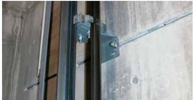
Befestigung einer Führungsschiene im Aufzugbau
