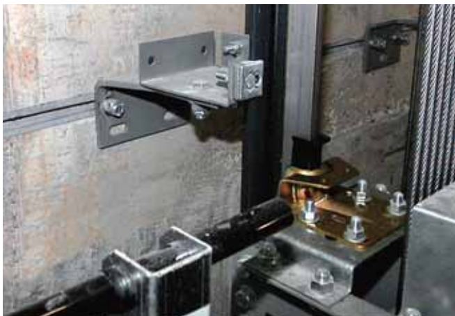
Befestigung von Führungsschienen
