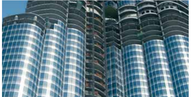
Befestigung einer Curtain Wall-Fassade
