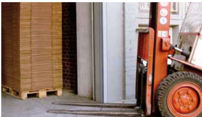
Kantenschutzwinkel an Wandecken in einem Industriegebäude
