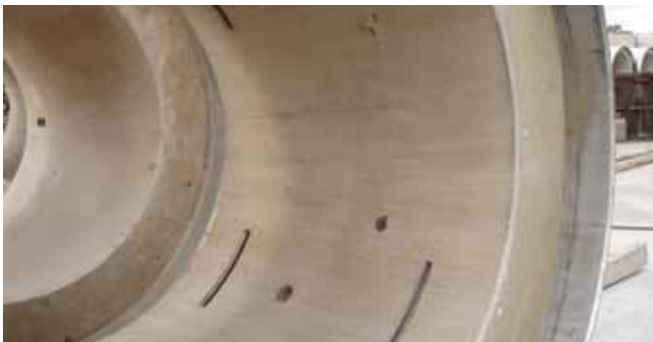
Versorgungsrohre mit gebogenen Ankerschienen
