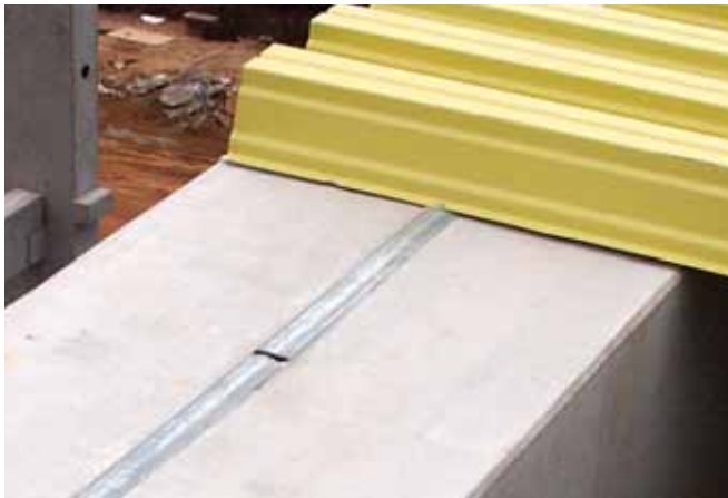
Trapezblechbefestigung im Dachbereich
