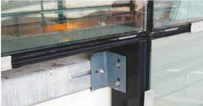
Befestigung einer Curtain Wall-Fassade
