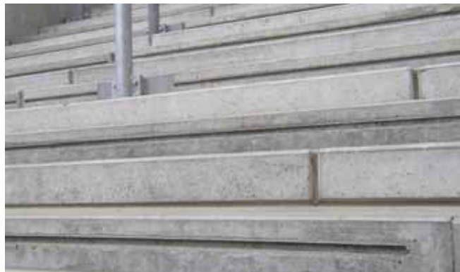
Befestigung Geländer, Stehtribüne RheinEnergieStadion/Köln
