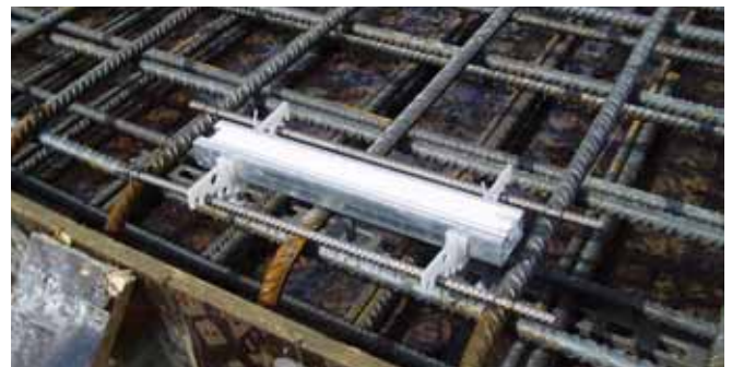
Befestigung mit HALFEN ChanClip (siehe → 2.2.2)
