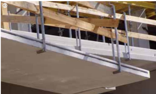
①-④: Befestigung von Geländern, Multifunktionshalle/Berlin
