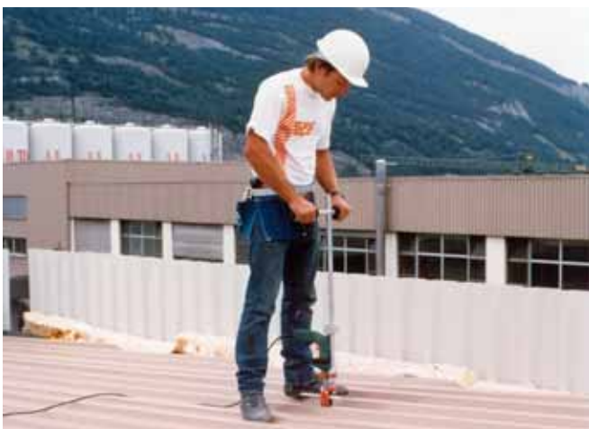
Verschraubung der Stahltrapezbleche mittels Selbstbohrschrauben
