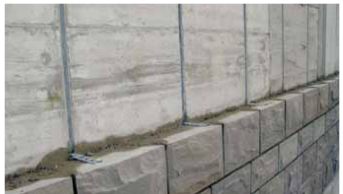
Maueranschluss mit HALFEN ML
