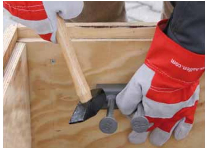
Halfenschienen an die Schalung annageln
