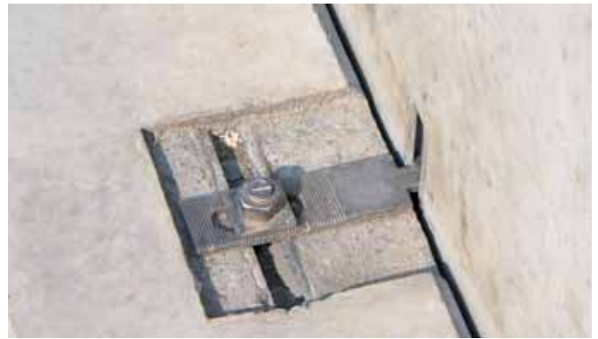
HALFEN Verankerungslasche HKZ mit gezahnter Gegenplatte
