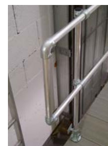
Garde-corps continu et fermé pour éviter les accidents
