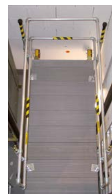
Garde-corps continu et fermé pour éviter les accidents
