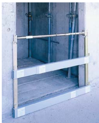
Variante 1: Protection partielle d'entrée de gaine d'ascenseur
