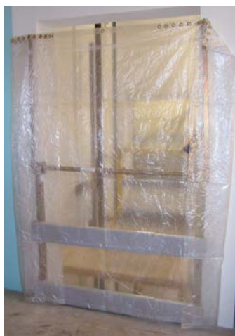
Variante 2: Protection étendue d'entrée de gaine d'ascenseur
